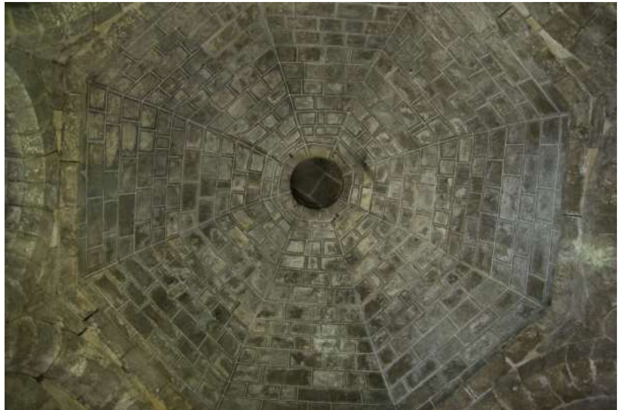
Un plafond octogonal aux pierres assemblées avec précision pour la chapelle St Clair d'Aiguille.
